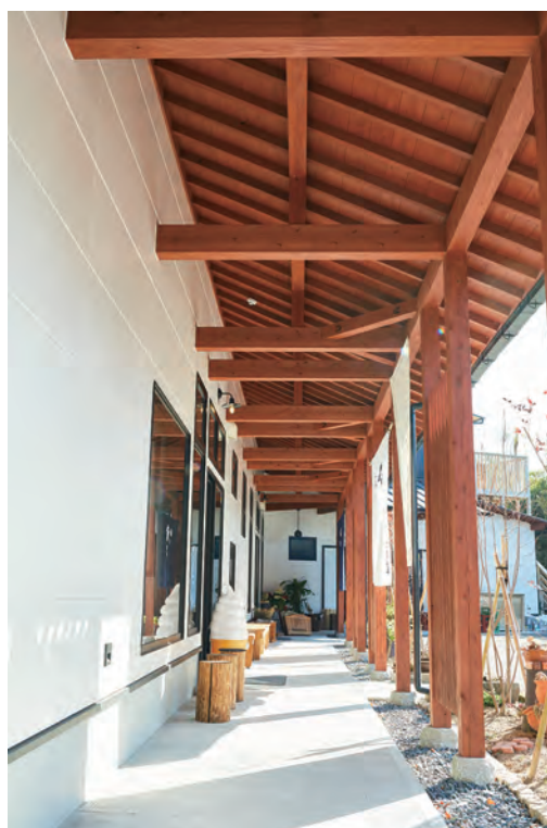
外廊下の天井も木材で作り、雰囲気統一
