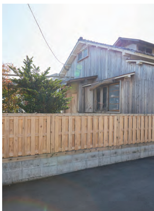
自身で作った木塀。ブロック塀の上に木塀を設置
